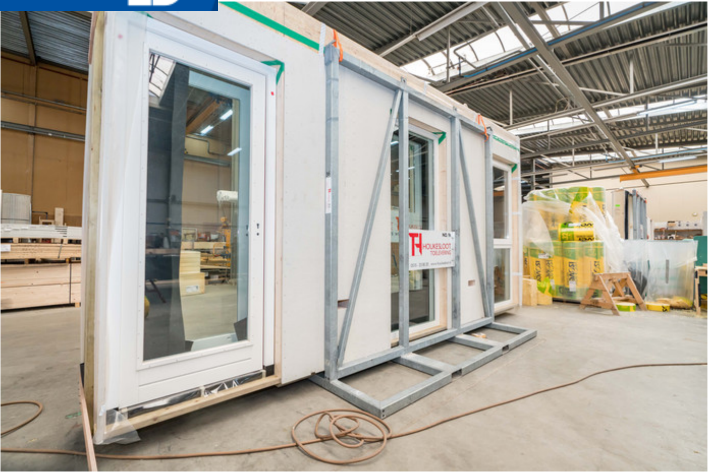
▲ De houten flexwoningen die corporatie Sint Trudo aan de Quinten Matsyslaan in Eindhoven laat bouwen, worden in de fabriek in elkaar gezet. © Friso BV/Sint Trudo
